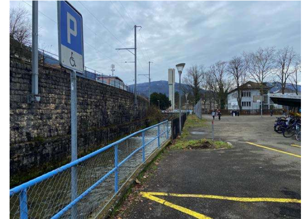
Le grand mur de soutènement ferroviaire au sud.
