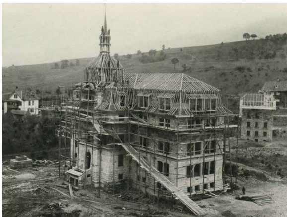
Pose de la charpente du collège en 1902.
